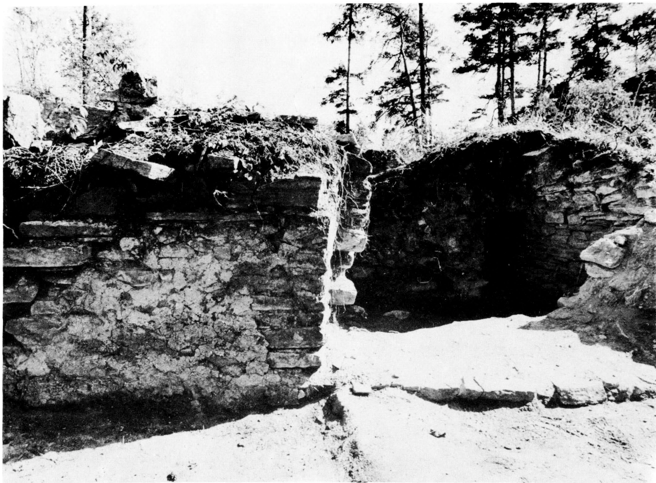
11 Bukov (okr. Žďár nad Sázavou), průzkum hradu, vstup do kuchyně (?) s dochovaným levým ostěním, vpravo její jihozápadní zeď do nadvoří s výběhem valené klenby
