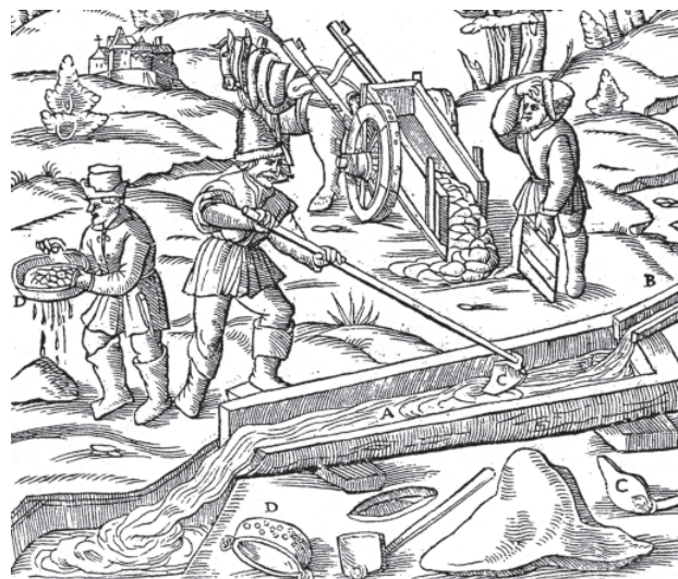
Obr. 17. Prádl s umělým přívodem v dlabaných korytech, podle G. Agricoli, mědiryt 1556 (Ježek – Hummel 2001).
