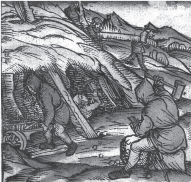
Obr. 5. Těžba v dole, ruční roztloukání rudy a vystrojování dolů. Dřevoryt z díla Ulricha Rüllein von Calv s názvem Eyn wohlge-rechnet nützlich Büchlein, wie man Bergwerk suchen und finden soll, okolo roku 1500.
