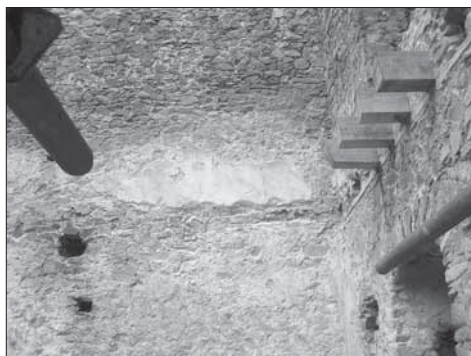
Obr. 8. Ukázka osazení stropních trámů a konzervované interiérové omítky. Někde zachován původní povrch, někde jen jádro omítky.
