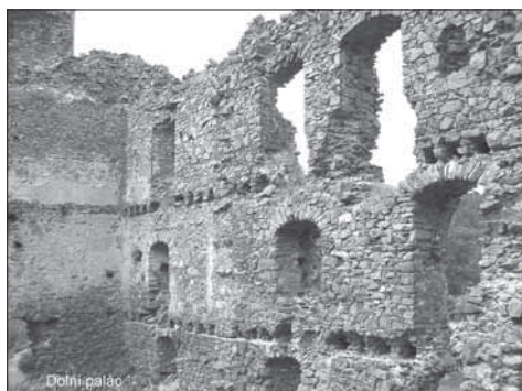
Obr. 5. Dolní palác před opravou.
