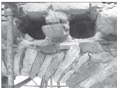
Obr. 6. Okenní záklenek a kapsy stropních trámů dolního paláce. V líci zdiva je otisk prkna, na kterém byly trámy uloženy.
