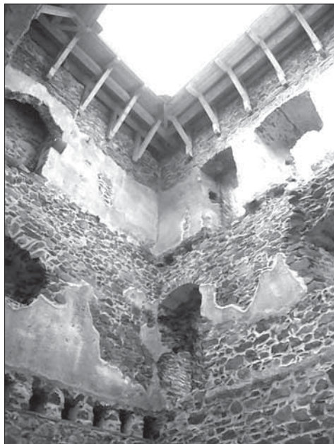
Obr. 16. Stříška pro ochranu interiéru horního paláce, kde jsou zachované části omítek a architektonické články.
