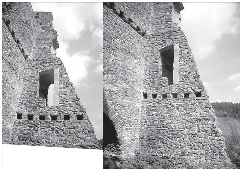
Obr. 15. Stabilizační opěrák. Opěrák má jen staticky nezbytný rozsah, pro odlišení novotvaru je pravá špaleta okna vyzděna z cihel.
