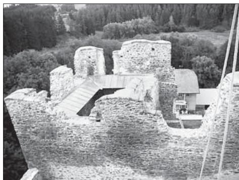
Obr. 18. Koruny horního paláce kryté olovem a střecha krytá titanizinkem (pohled z věže).
