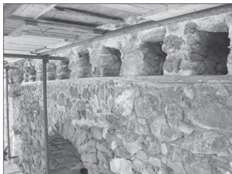
Obr. 7. Kapsy stropních trámů. Doplněno prkna, na kterém byly trámy uloženy, kapsy dozděny.
