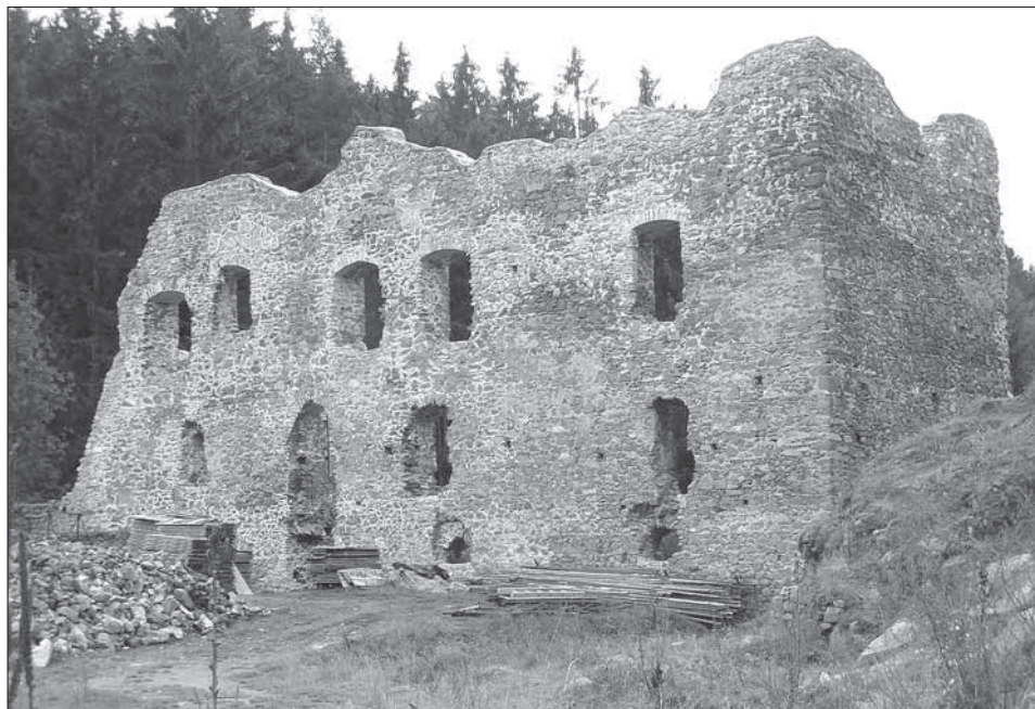
Obr. 9. Dolní palác po opravě. V místech, kde nebyly ve vnějším líci doloženy záklenky, byla klenba provedena z cihel.
