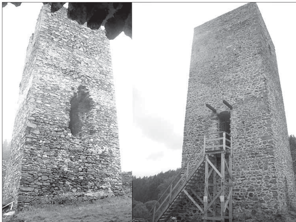
Obr. 22. Horní věž před opravou a po opravě. Schodiště postaveno v místě doloženém archeologickým výzkumem, v původních kapsách osazeny předpokládané konzoly pro zvedání mostku. Abb. 22. Oberer Turm vor und nach der Restaurierung. Die Treppe wurde an der Stelle errichtet, die durch die archäologische Untersuchung belegt ist. Die mutmaßlichen Konsolen für die Zugbrücke wurden in die ursprünglichen Taschen gesetzt.
