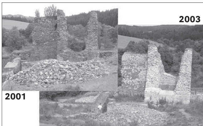
Obr. 4. Dolní věž před opravou a po opravě. Dozdívky jen pro ochranu koruny a stabilizaci, zdivo se zachovanou maltou v líci neopravováno, drnová koruna, ponechán jalovec chránící korunu zdi.
