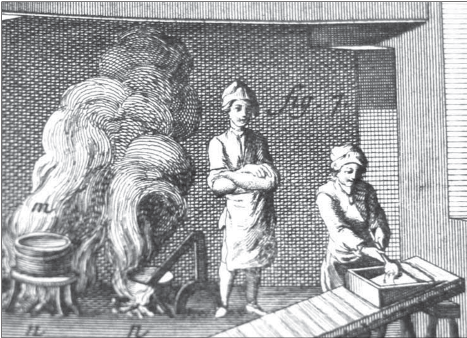
Obr. 17. U vybraného zboží se před prodejem prováděla dodatečná povrchová úprava ušlechtilým materiálem (často se jednalo o stříbro). Tím špendlíky získaly na hodnotě. Podle Diderot 1773, pl. III.
