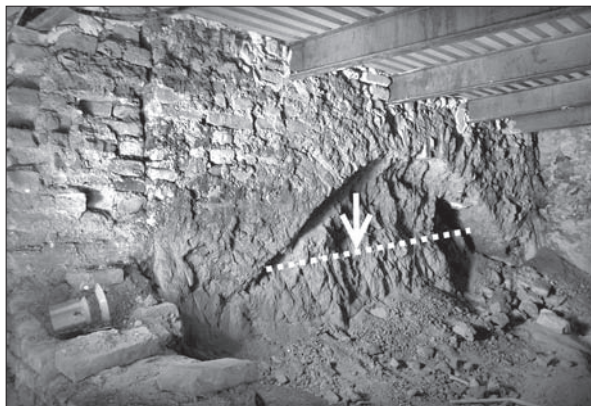
Obr. 7. Statický základový oblúk pod renesančnou priečkou. Šípka a bodková čiara označujú polohu rozhrania medzi rastlým terénom – sprašou a nesúdržným zásypom. Foto P. Grznár, M. Zelina.
