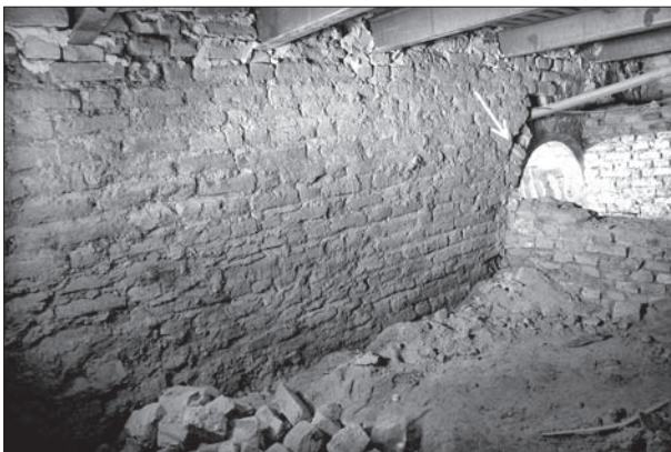
Obr. 9. Exteriérové líce východnej steny pivnice odkryté utilitárnym výkopom s fragmentom muriva staršej šije. Foto P. Grznár, M. Zelina.
