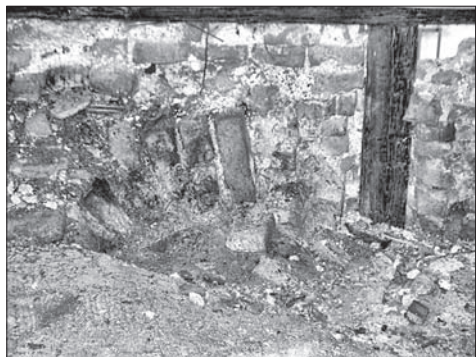
Obr. 6. Torzo pôvodného (?) okna v dnešnom podkroví. Foto J. Žuffová.
