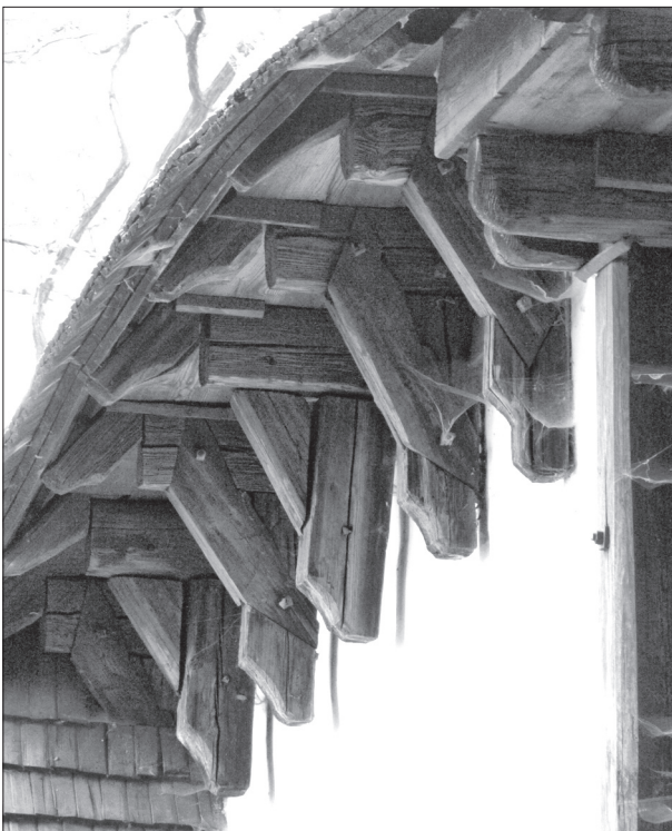
Obr. 7. Valašské Meziříčí, kostel sv. Trojice. Detail konzolovitých zarážek na severní straně presbytáře, pohled od západu.
