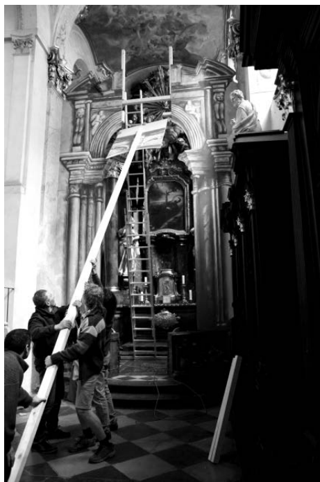
Abb. 6. Bau der mittlern Teil des Hl. Grabes.
