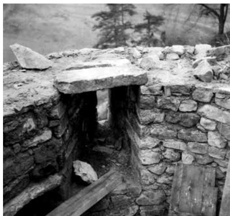
Obr. 15. Hrad Zvíkov, okres Písek. Výstavba horní části bašty na východním nároží hlavní hradby severního nádvoří na konci 50. let minulého století. Podle Fuka b. d.
