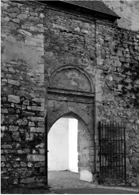
Obr. 12. Hrad Zvíkov, okres Písek. Železná brána v severní hradbě. Horní část brány a opěrák vlevo, obsahující velký počet raně gotických architektonických článků, pocházejí z barokní úpravy v roce 1710. Foto J. Varhaník, 2015.
