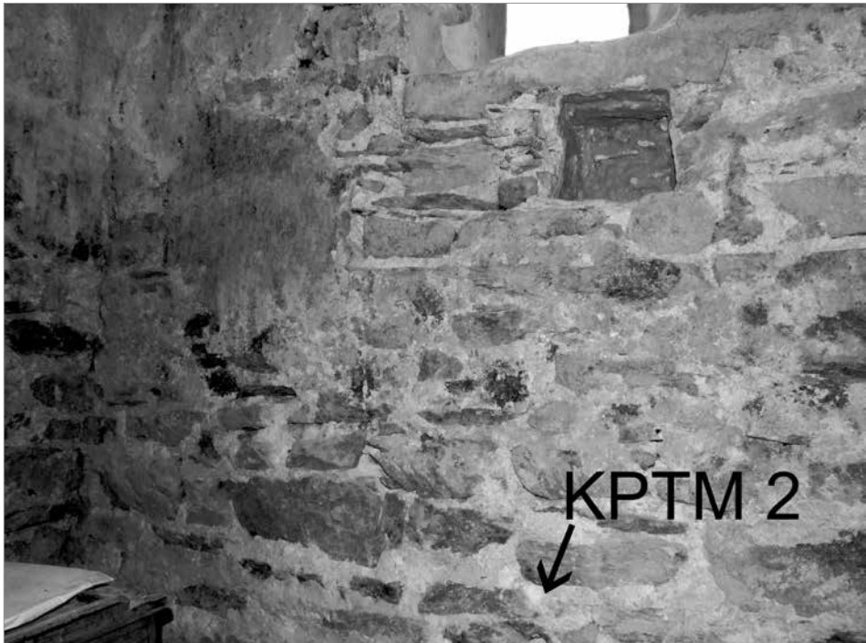
Obr. 4. Štruktúra muriva v južnej stene presbytéria s miestom odberu vzorky. Foto M. Bóna, 2014.
