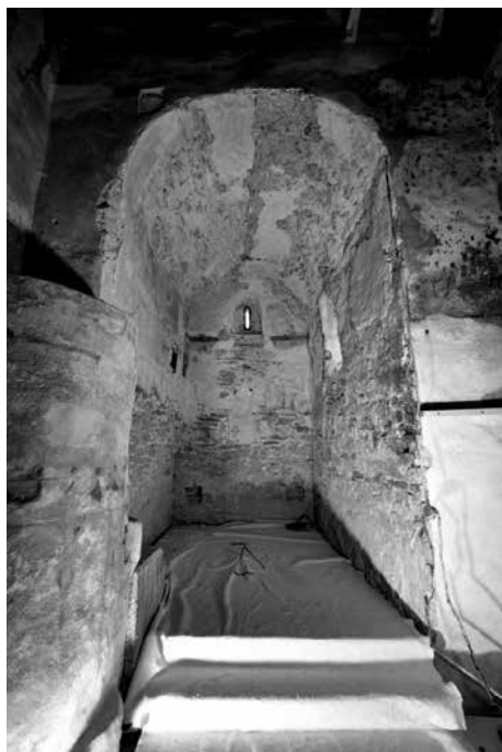
Obr. 2. Celkový pohľad do presbytéria. Foto M. Keleši, 2012. Abb. 2. Gesamtansicht des Chorraums. Foto M. Keleši, 2012.
