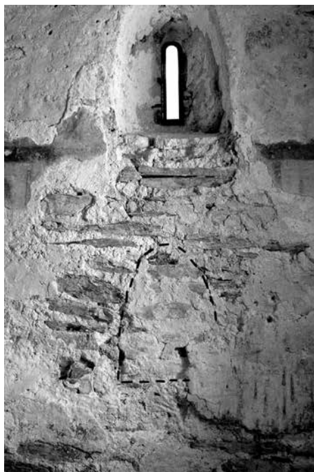
Obr. 3. Nález zamurovaného otvoru vo východnej časti presbytéria. Foto M. Keleši, 2012. Abb. 3. Fund einer zugemauerten Öffnung im Ostteil des Chorraums. Foto M. Keleši, 2012.
