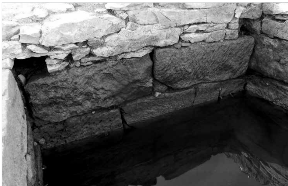
Obr. 10. Chrudim, Masarykovo náměstí. Rituální lázeň (mikve). Jižní stěna s lůžky pro trámy, které mohly nést poklop, zakrývající jižní díl lázně. Pohled od severovýchodu. Foto J. Frolík.
