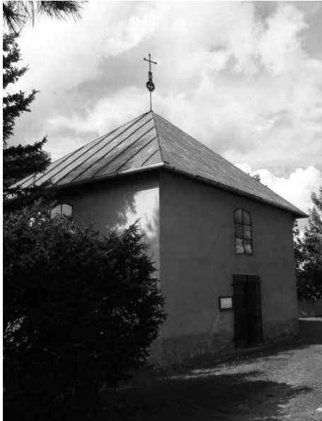
Obr. 16. Nížkov, kostnice. Zdroj http://www.region-vysocina.cz/kostnice-cx1114 .
