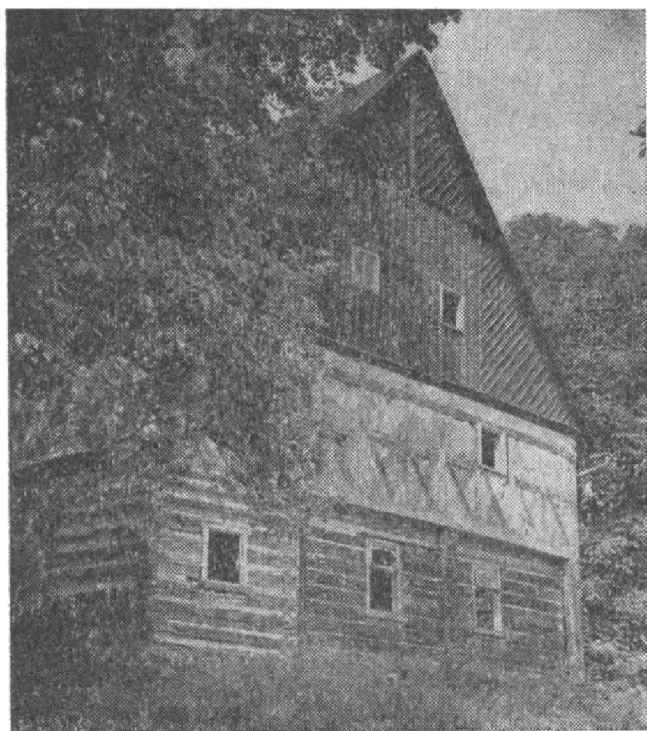
Obr. 10. Bohatice čp. 5 (okres Česká Lípa), obytná část domu bývalé rychtářské usedlosti s jádrem asi z přelomu 17. a 18. století. V podezdívce je část okoseného pozdně gotického ostění. Foto J. Škabrada, 1968.
