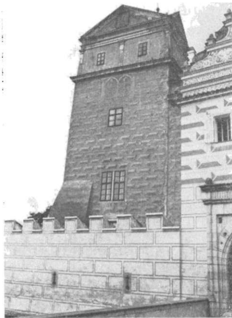
Obr. 14. Horšovský Týn hrad, okr. Domažlice. Věž zbudovaná nad presbytářem starší kaple v renesanční úpravě. Foto: T. Durdík.
