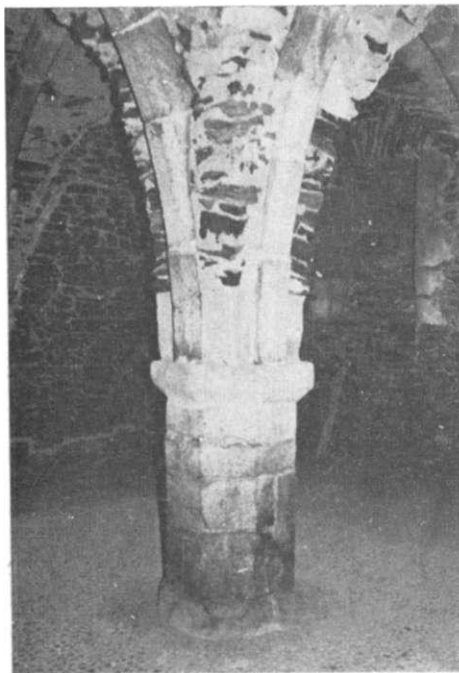
Obr. 16. Horšovský Týn hrad, okr. Domažlice. Střední pilíř severní klenuté místnosti starší fáze polozařezaného přízemí západního křídla. Foto: T. Durdík.
