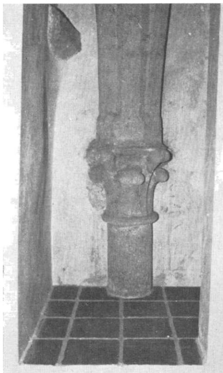
Obr. 2. Horšovský Týn hrad, okr. Domažlice. Starší kaple v jihovýchodním nároží, hlavice klenební přípory. Foto: T. Durdík.
