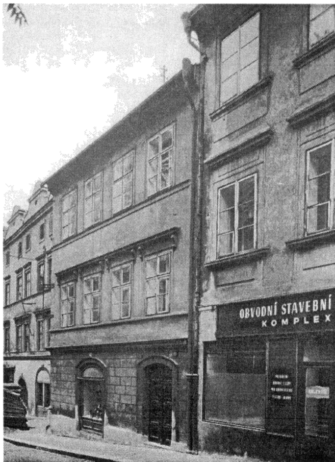
Obr. 7. Průčelí domu čp. 247, který přiléhal k boku brány v celé její šířce, sousední dům vpravo (čp. 246) přiléhal k obvodu předbraní.
