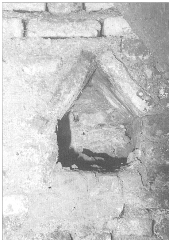
Obr. 10. Jedna z pôvodnej dvojice ník na uloženie osvetľovacieho telesa, západná stena spodného podlažia.
