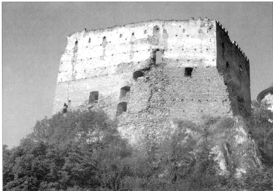
Obr. 3. Lubovňa – východný palác, pohľad zo severovýchodu.
