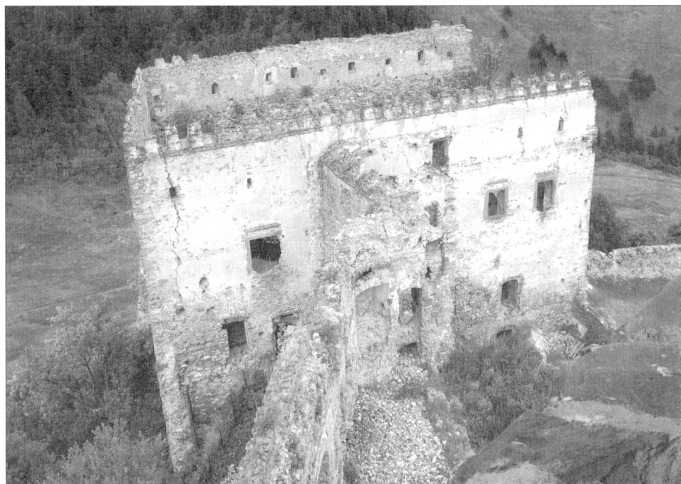
Obr. 4. Lubovňa – východný palác, pohľad z veže.
