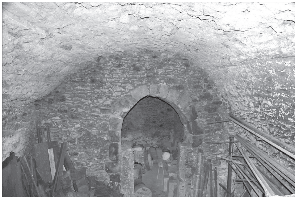
Obr. 11. Suterén obytné věže, pravý hloubkový trakt s příčkou prolomenou průchodem, který je ukončen lomeným obloukem vyzděným z klenáků v podobě pískovcových armovacích kvádrů. Foto I. Peřina 2006.
