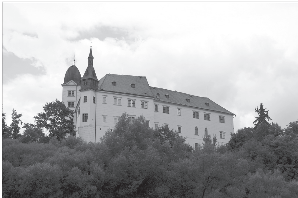
Obr. 1. Hrubý Rohozec od východu, pohled z údolní nivy řeky Jizery. Foto I. Peřina 2006.
