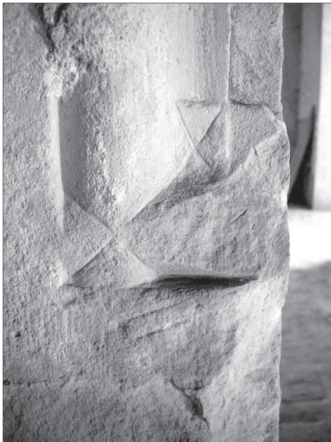
Obr. 10. Kroměříž, zámek, detail profilace zbytku okenního ostění v severozápadní stěně třetího nadzemního podlaží věže.
