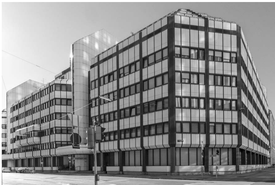
Abb. 3: Das neue Gebäude des Österreichischen Staatsarchivs in Wien Erdberg (Foto: Viennaphotographer, Wikimedia Commons).
