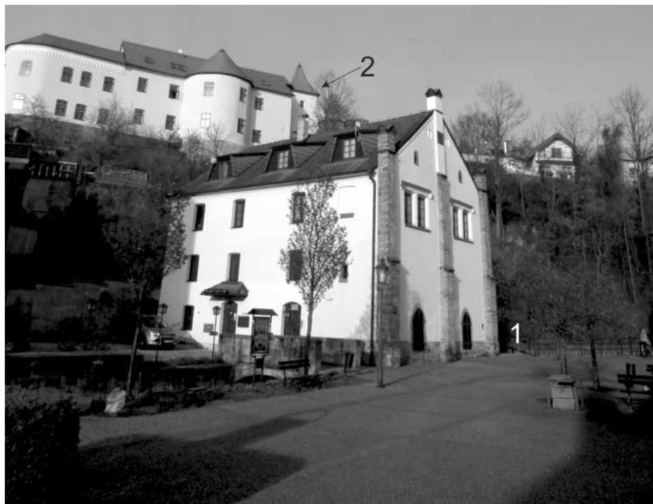
Obr. 8. Chrudim, ulice U Vodárny čp. 111/II. 1 – Budova s čerpacím zařízením postavená v roce 1670, současný vzhled objektu dala přestavba v roce 1852. 2 – Vodní rezervoár se nalézal v hranolové věži výše. Stav v roce 2023. Foto J. Musil.
