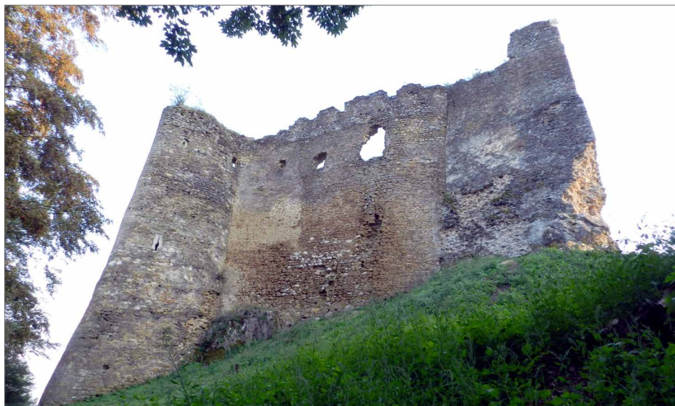
Obr. 4. Hrad Čičava, severný obvod hradného jadra vľavo s baštou a vpravo hrotom valcovej veže. Foto M. Bóna, 2016.
