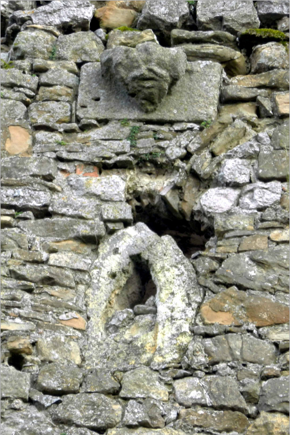
Obr. 11. Hrad Čičava, stredoveký maskarón a strieľňa na fasáde severovýchodnej bašty hradného jadra. Foto M. Bóna, 2016. Abb. 11. Burg Čičava, mittelalterlicher Maskaron und Schießscharte an der Fassade der nordöstlichen Bastei der Kernburg. Foto M. Bóna, 2016.
