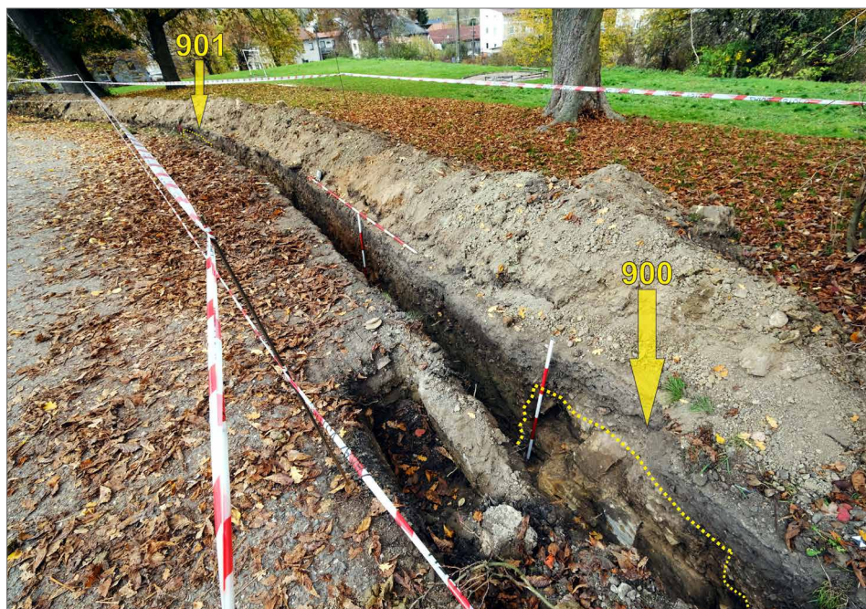
Obr. 9. Pohled do výkopu od východu na relikty zdí (stratigrafické jednotky 900 a 901) tvořených pískovcovými lámány mi kameny spojenými maltou. Autor J. Unger, upravil P. Drnovský.
