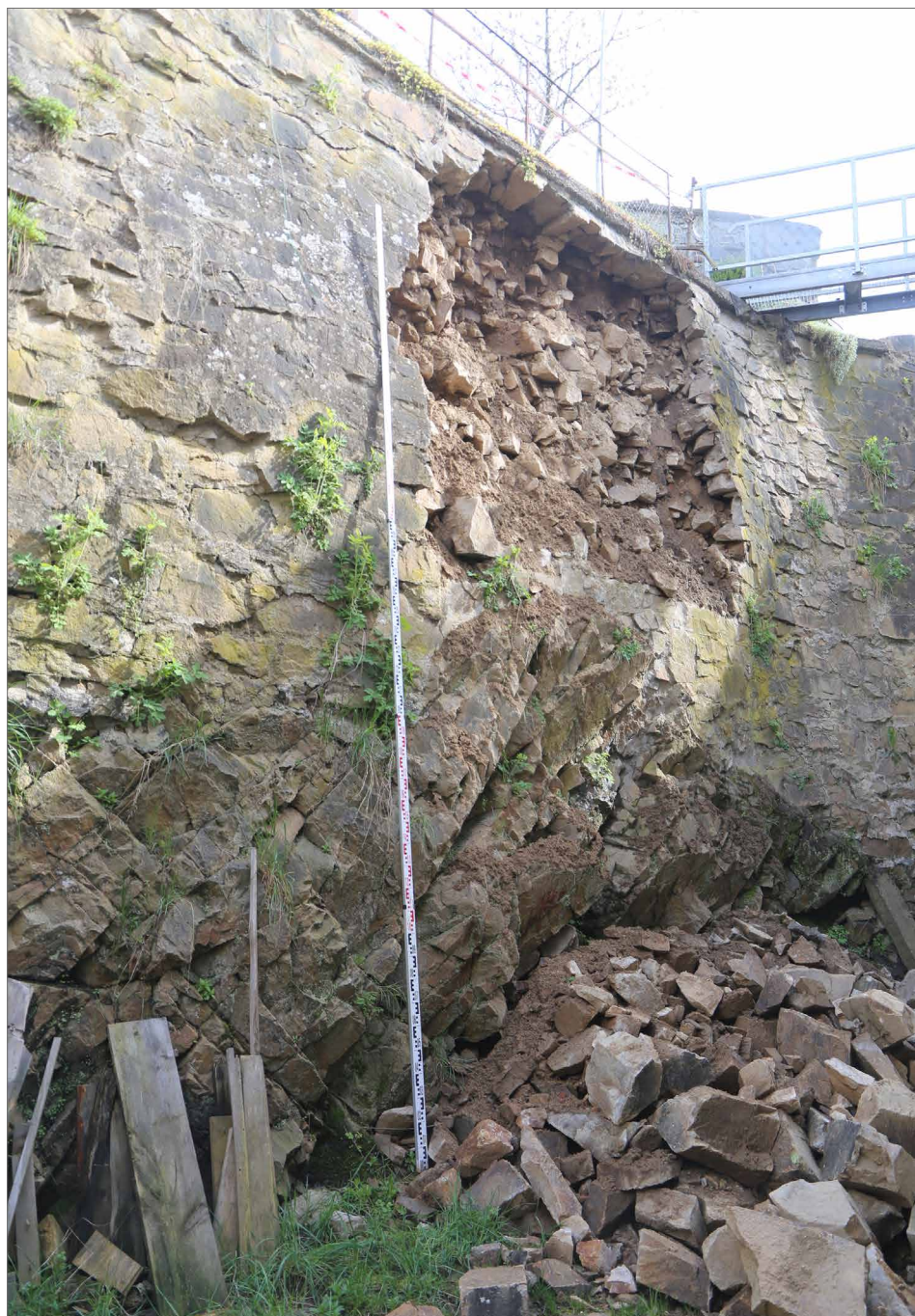
Obr. 15. Dvorek domu Fibichova ulice 948/81. Stěna JJZ bastionu (fortifikační prvek 8) s odpadlou částí recentní kamenné plenty. Za ní je viditelné lomové zdivo smíšené se zeminou, snad pozůstatek armování lince bastionu. Archiv Archaia Brno, z. ú.
