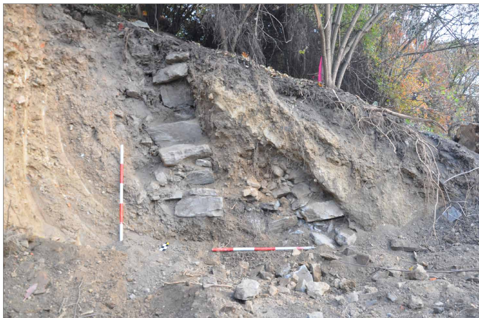
Obr. 14. Armování kurtiny mezi bastionem Spielberg a bastionem před Českou branou. Archiv Archaia Brno, z. ú.
