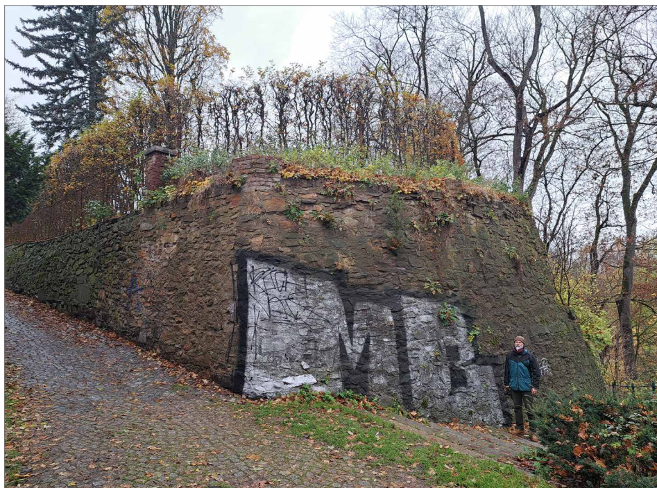
Obr. 16. Část fortifikačního prvku 2. Současný stav, kamenné obložení spojujeme až s mladšími terénními úpravami. Foto Š. Kochan.
