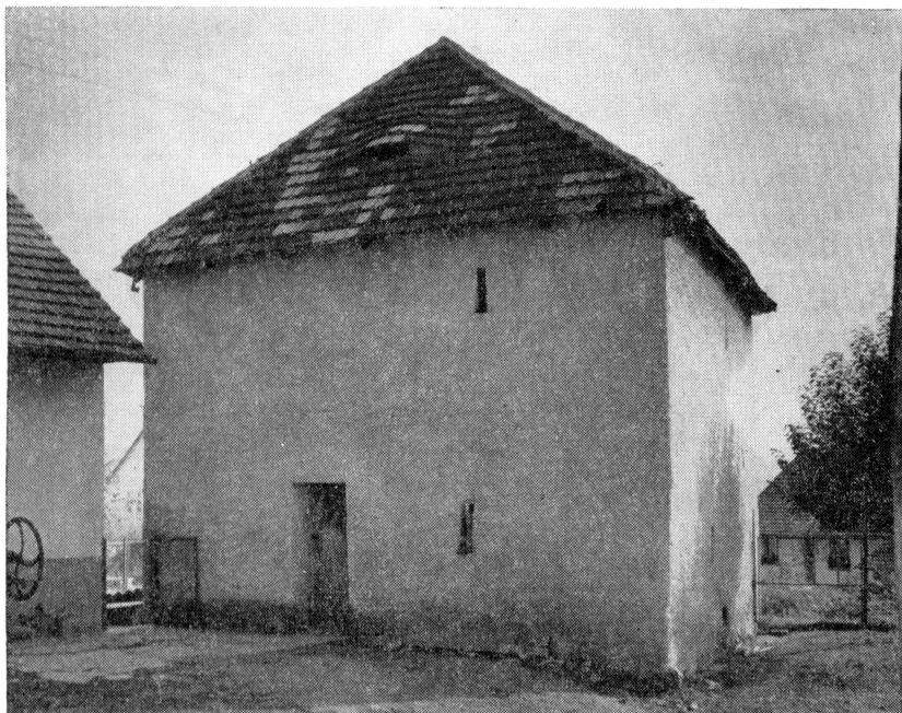
Obr. 4. Ostřetice (okr. Klatovy), čp. 14. Celkový pohled na sýpku od S ze dvora usedlosti.
