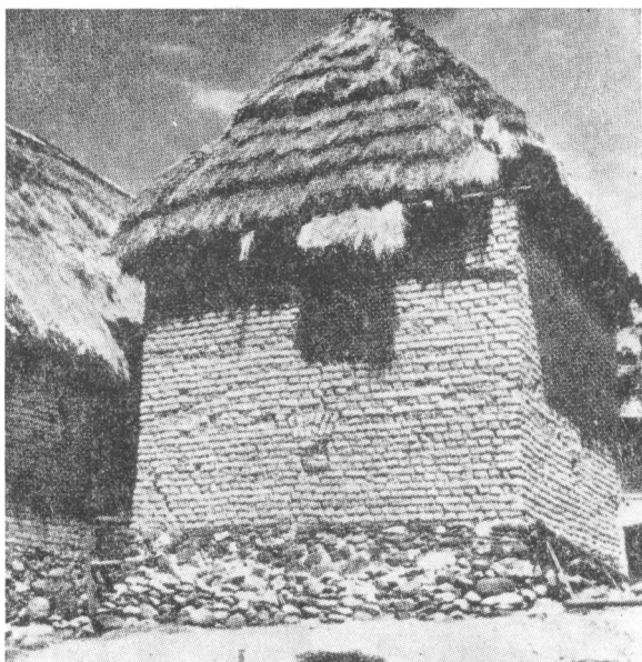
Obr. 11. Sebedražie. Komora z nepálených tehál. (Podľa V. Mencľa).
