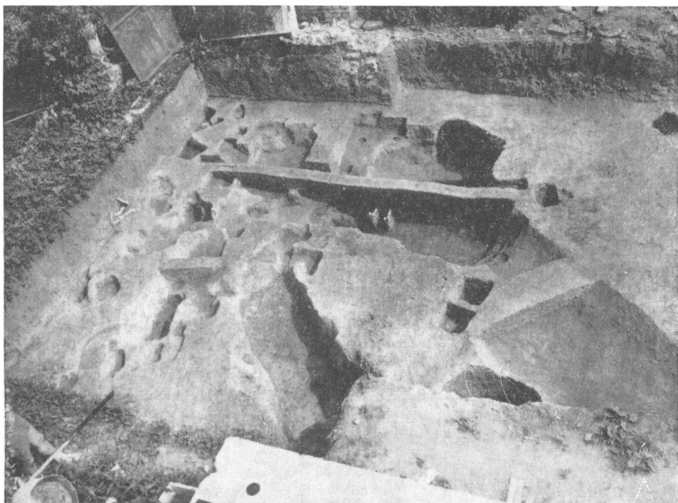
Obr. 8. Strachotín (okr. Břeclav). Situace výzkumu v intravilánu obce na jaře 1981 (čp. 99). Zachyceny vstupy do středověkých lochů, žlab a další objekty.
