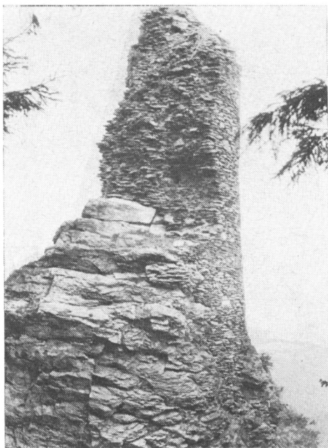
Obr. 5. Hrad Koberštejn, torzo palácové stavby.
