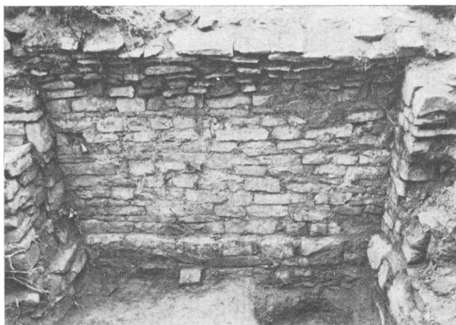
Obr. 7. Odkryv podvěží (pohled na jižní straně).
