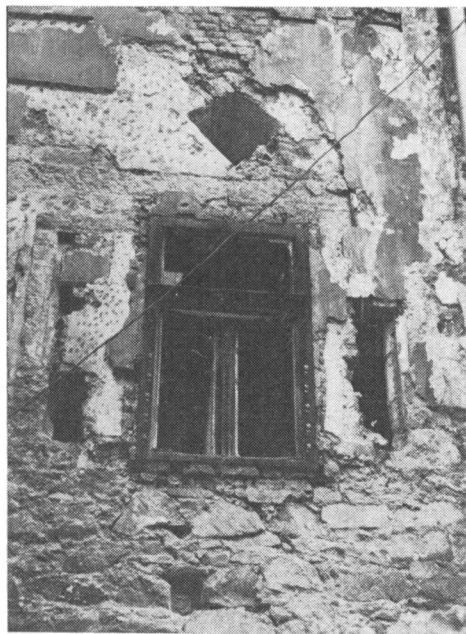
Obr. 15.–16. Banská Štiavnica (okres Ziar nad Hronom). Varianty vnějšího utváření větracích otvorů ve fasádách s šikmými, ven rozevřenými špaletami.
