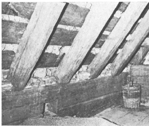
Obr. 4–5. Krnin čp. 3 (okr. Český Krumlov). Izolační dřevohlinitá konstrukce (lepenec) v podstřeší zadní patrové komorové části pozdně gotického domu – usazení krokvi, nesoucích bednění a mazaninu, na roubeném věnci, a pohled vzhůru ke hřebeni střechy mezerou mezi vnějším licem hliněné izolace a vrchním krovem s krytinou.
