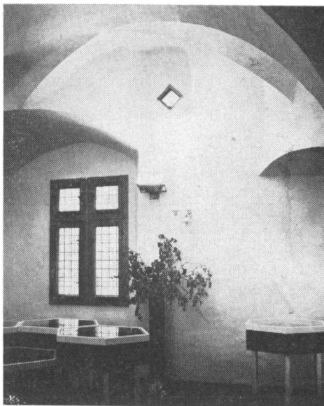
Obr. 11.–12. Kremnica (okres Ziar nad Hronom). Příklady větracích otvorů ve stěnách pozdně gotických domů – šikmé průrazy s omítkovými paspartami a situace otvoru v prostoru, klenutém sklípkovou klenbou.
