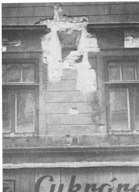
Obr. 15.–16. Banská Štiavnica (okres Ziar nad Hronom). Varianty vnějšího utváření větracích otvorů ve fasádách s šikmými, ven rozevřenými špaletami.
