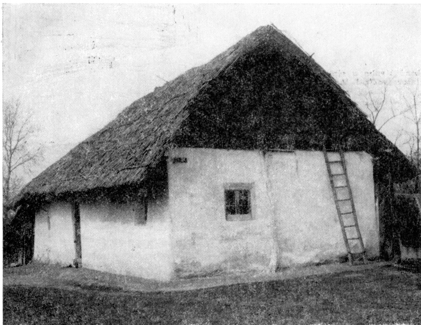
15. Hilněň dům se sochovou konstrukcí střechy, Martovec čp. 211, o. Komárno. Archiv SNM Martín, foto P. Hanula 1963.
