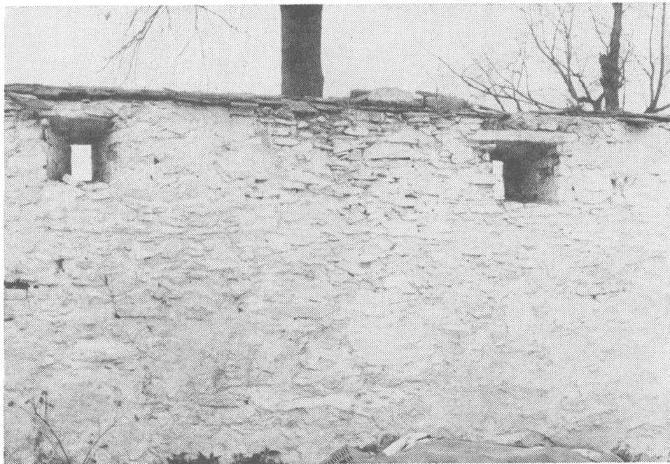
Obr. 7. Branovice, k. ú. Dobšice. Střílnová okénka v severní ohradní zdi dvora. Foto autor.
