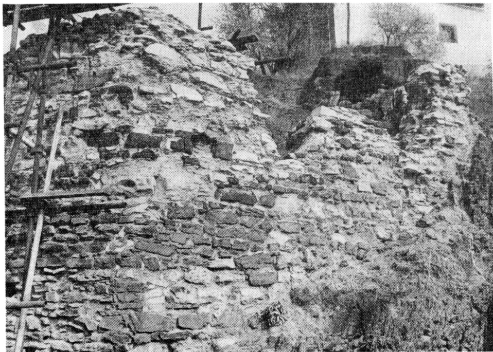
Obr. 7. Praha 2, Vyšehrad. Libušina lázeň — jižní okosené nároží stavby s horní jeskyňkou. Foto V. Jílková.
