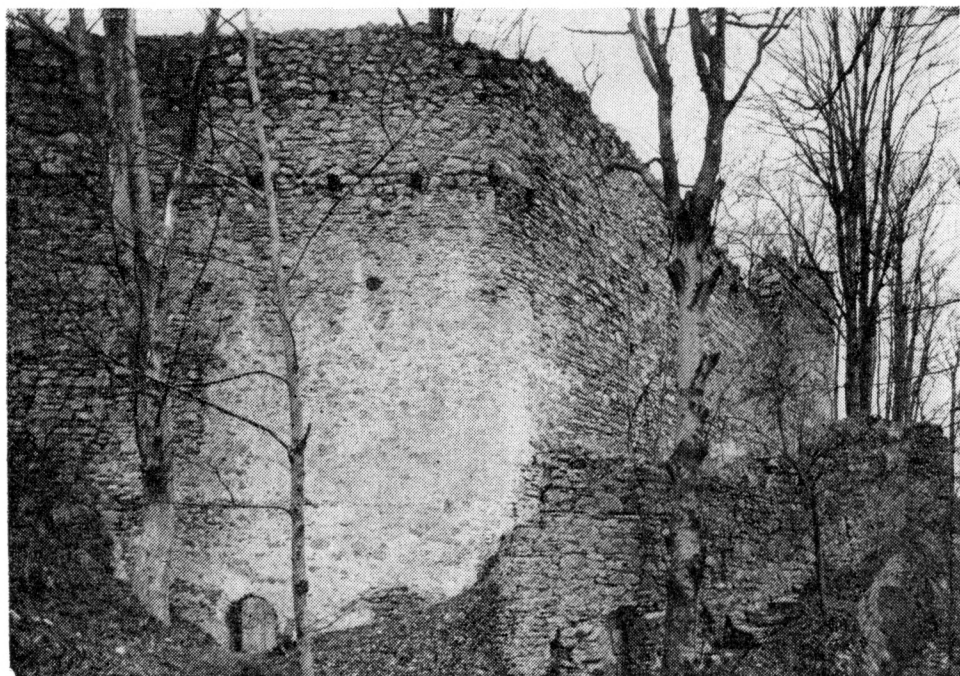
Obr. 7. Jižní část hradby předhradí, nadezděná a opatřená průchodem do parkánu v 13. století. Vpravo porušená parkánová hradba. Foto V. Hyhlík 1973, archiv SÖPP.
