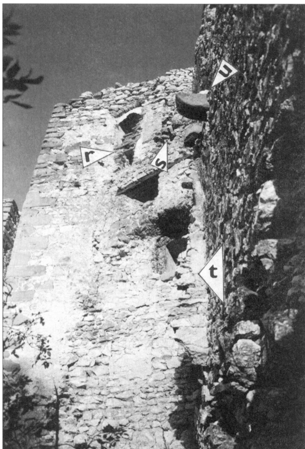
Obr. 2. Sústava prevétov v severozápadnom exteriérovom kúte horného hradu (označenie prevétov zodpovedá označeniu na obr. 1A). Foto autor, VIII. 1998.
