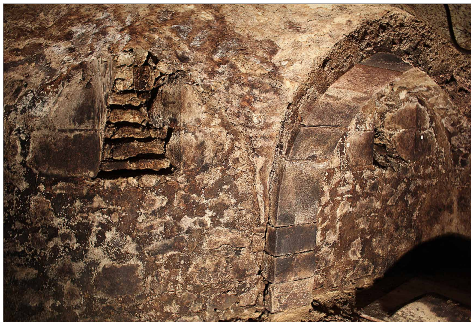
Obr. 14. Celkový pohľad na južnú stenu.
