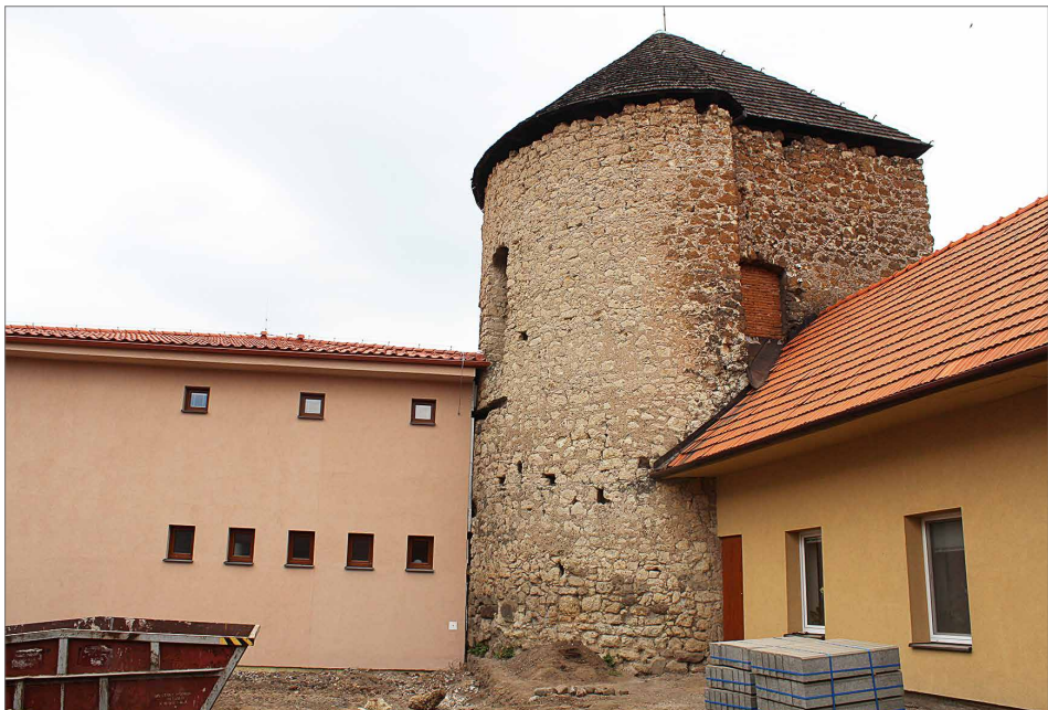
Obr. 5. Pohľad na baštu z východnej strany. Vpravo novoveká budova na mieste karnera. Abb. 5. Blick auf die Bastei von der Ostseite. Rechts neuzeitliches Gebäude an der Stelle des Karners.
