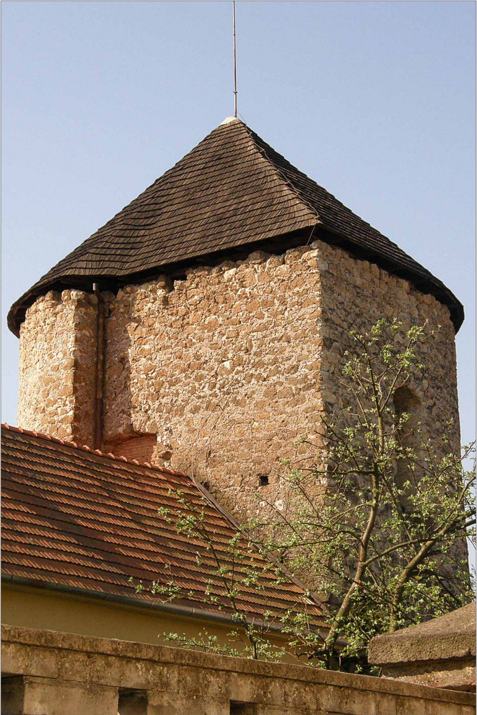
Obr. 6. Pohľad na baštu zo severovýchodnej strany. Viditeľné je zalomenie fasády, ktoré vzniklo rešpektovaním staršej stavby. Abb. 6. Blick auf die Bastei von der Nordostseite. Zu sehen ist die durch Respektierung eines älteren Baus entstandene Abknickung der Fassade.
