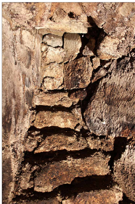
Obr. 15. Detail južného okna.
