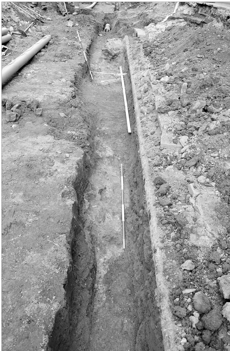
Obr. 15. Situácia 7 – murivá kolmo napojené na vonkajšiu hradbu (v pozadí), zachytené na dne výkopu.
