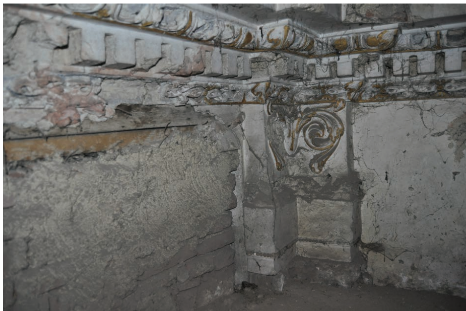
6) Zbytky výzdoby původního divadelního sálu zachovalé na půdě dnešní knihovny. (Foto autor)
