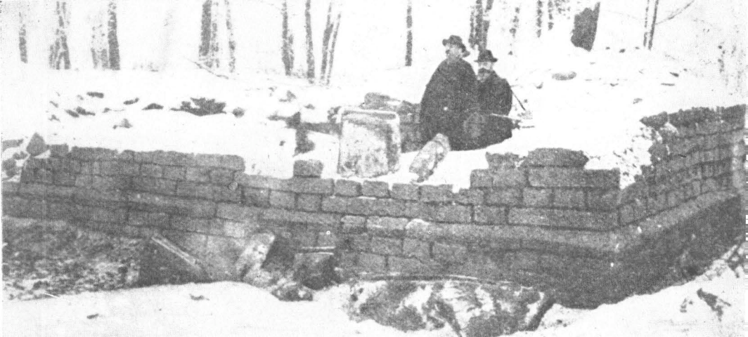
Obr. 17. Zbytky kamenné věže římského limitu u Schlossau i. O. (Fr. Koepp, Germania Rom. 2 I, tab. 11 č. 4).
