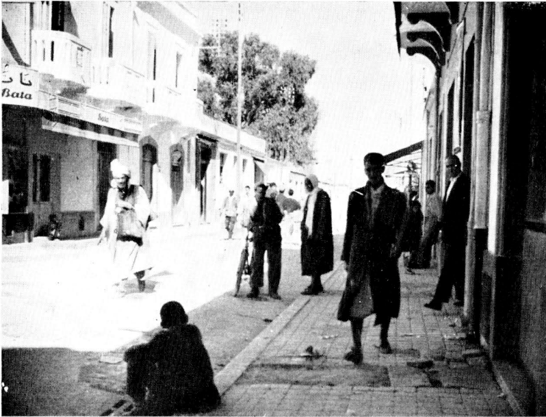
30. Malá města jsou středisky nevyspělého obchodu. Mezi nejvýznamnější patří zánovní prodejny fy Bata (Súk al-Arba). Foto R. Jeřábek 1961.
