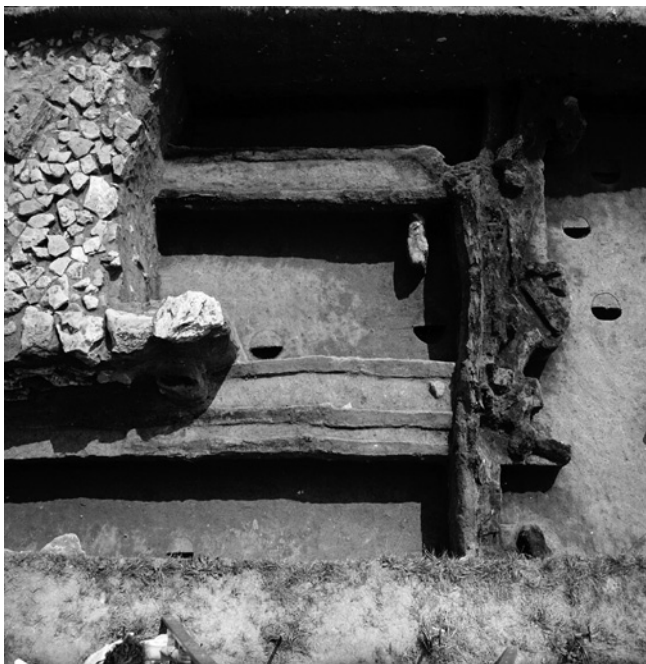
Obr. 107 – R03. Základové kleštiny.
