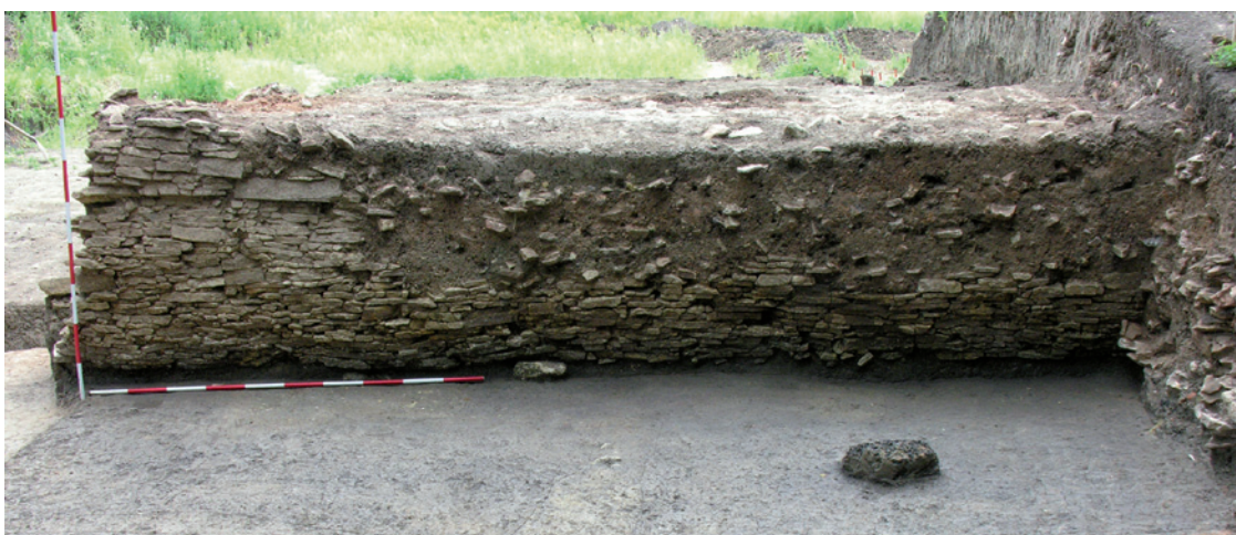
Obr. 135 – R19. Čelní kamenná zeď – čelní pohled od V.
