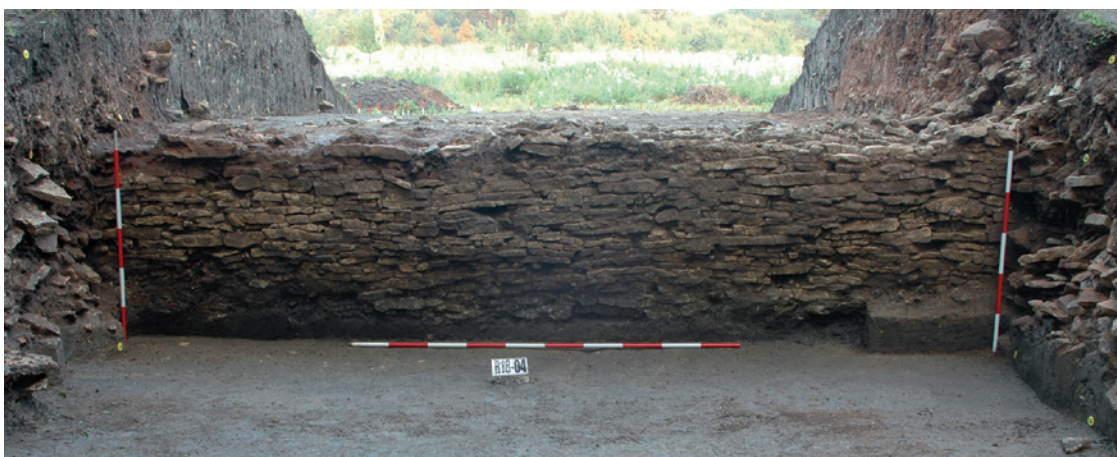
Obr. 134 – R18. Čelní kamenná zeď – čelní pohled od V.
