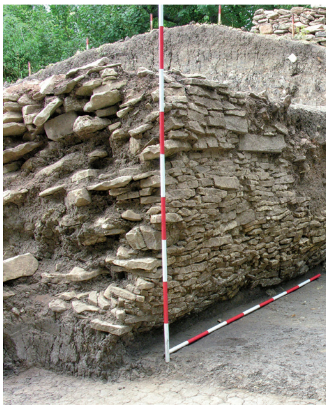
Obr. 139 – R19. Zaklonění a předsazení čelní zdi.
