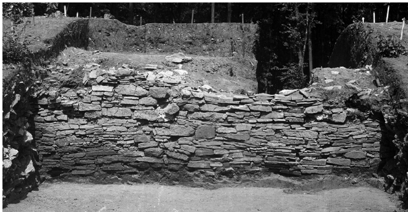
Obr. 132 – R01. Čelní kamenná zeď – čelní pohled.
