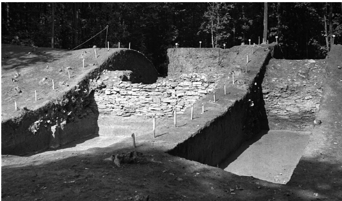
Obr. 133 – R01. Čelní kamenná zeď – pohled od V.
