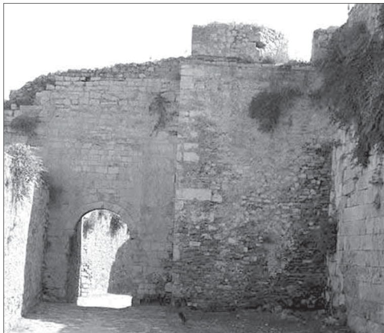
Obr. 13. Methóné – detail přístupového přihrádku před druhou branou, zdivo obsahuje množství antických spolií (archiv autora).
