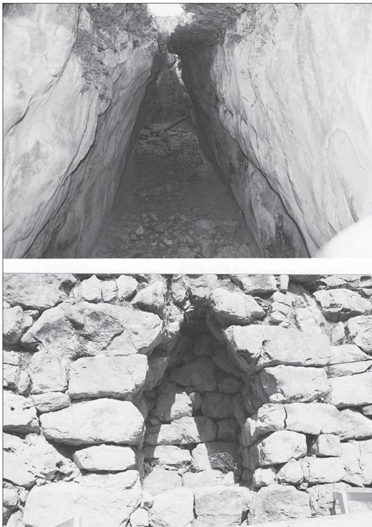
Obr. 3. Střechovitá klenba mykénského suterénu na Larisse (nahore), klenba z Týrinthu, tentokrát přečnělková (dole). Foto autor.
