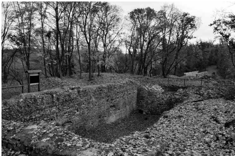
Obr. 20. Nový hrad u Kunratic. Stav hradního objektu v roce 2013 po provedených památkových úpravách a konzervaci hradního zdiva. Pohled od jihozápadu na sklep paláce, v pozadí nový most přes příkop. Foto J. Podliska, NPÚ.
