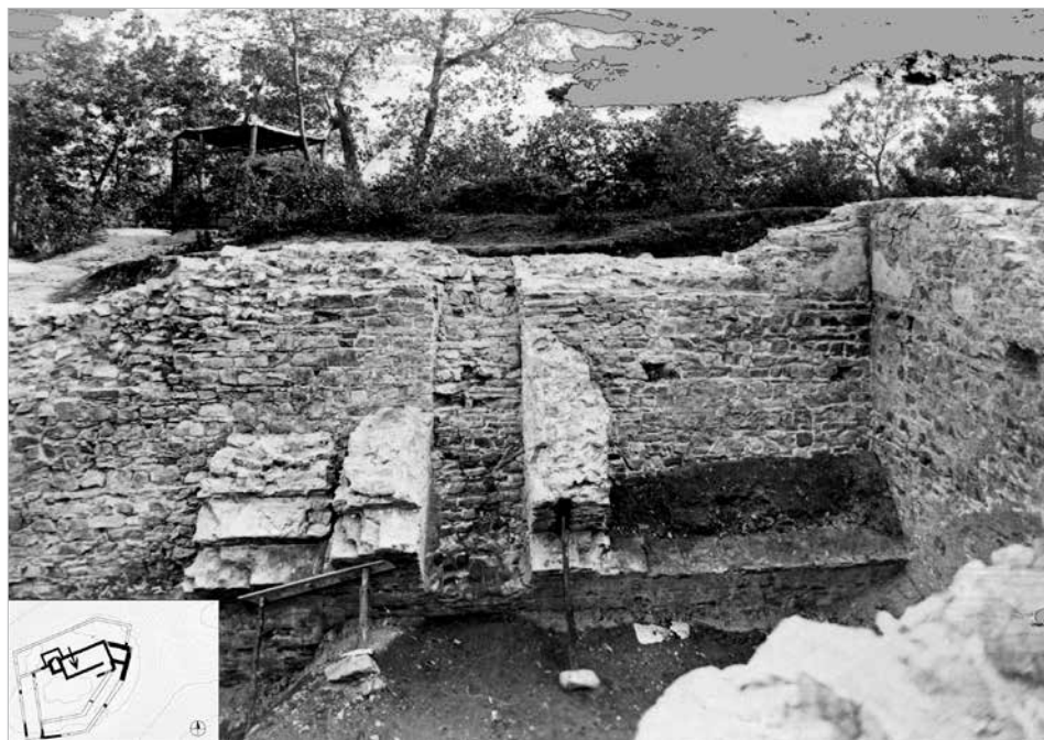
Obr. 15. Nový hrad u Kunratic. Detailní záběr na jižní stěnu suterénu velkého paláce s torzem klenebních pasů a větracího okna, pohled od severu. Stav při jejich odhalení v letech 1928 a 1929. ARÚ AV ČR, Praha, FT000081746.
