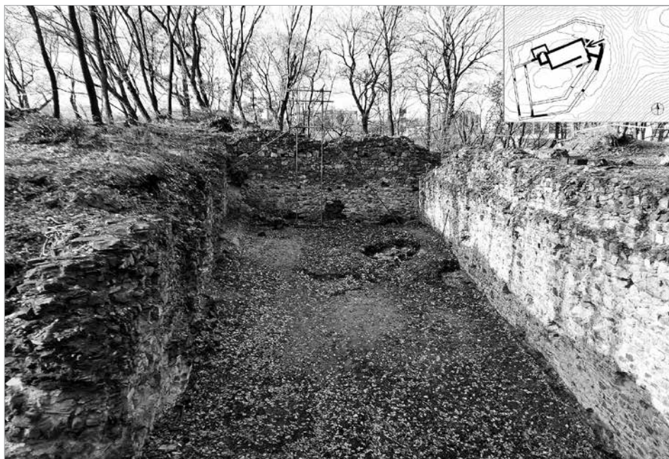
Obr. 7. Nový hrad u Kunratic. Srovnávací foto k obr. 6, stav objektu před zahájením rekonstrukčních prací v roce 2012. Foto F. Flek, NPÚ.
