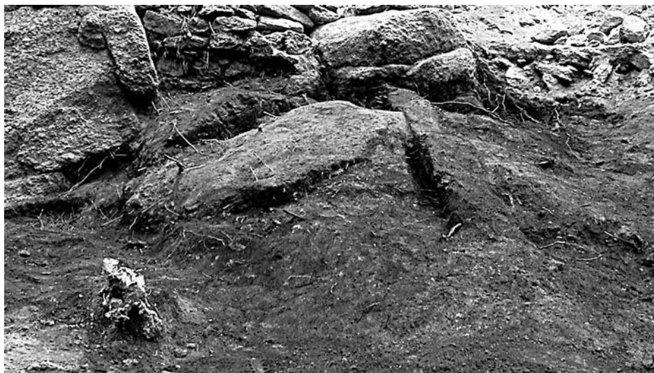
Obr. 14. Hrad Skály, okr. Žďár nad Sázavou. Nahromadění odpadků pod kuchyní na předhradí překrytých spáleništěm a mazanicí. Na pozadí patrné obloukovité ožehnutí skály.
