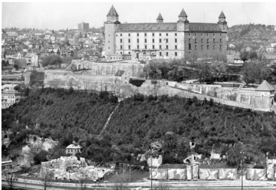
Obr. 2. Vodná veža na fotografii z obdobia výskumu v 70. rokoch 20. storočia. Zdroj Archív MÚOP.
