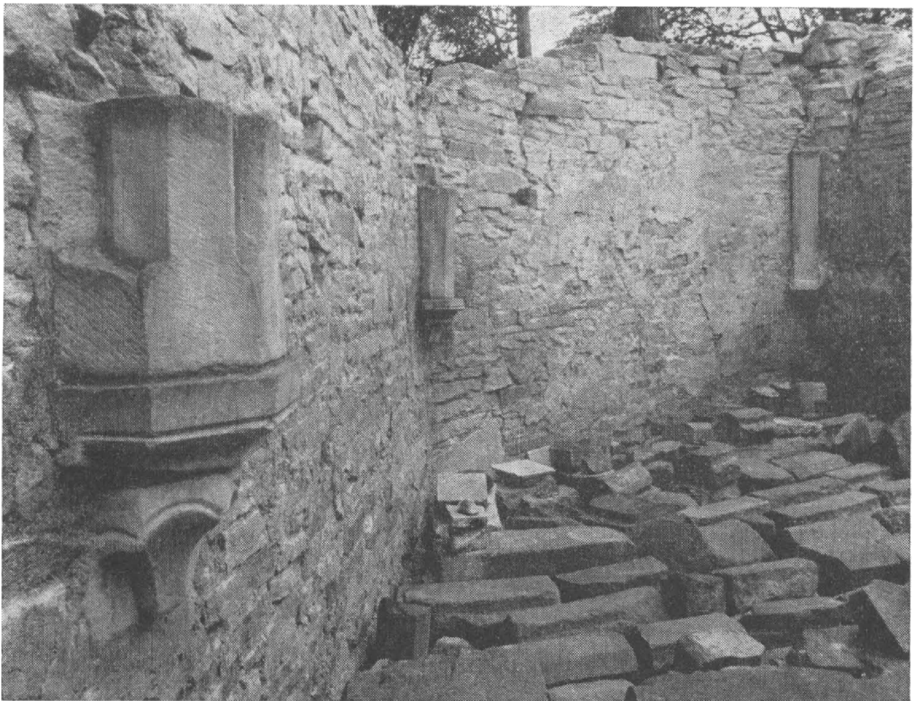
Obr. 2. Vizmburk – jižní síň s konzolami, západní část od východu. Foto K. Višek.
