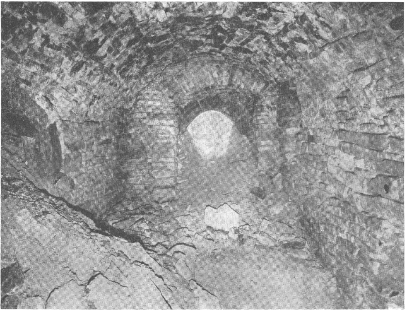
Obr. 3. Vizmburk – síň pod střední částí paláce od východu. Foto K. Vlček.
