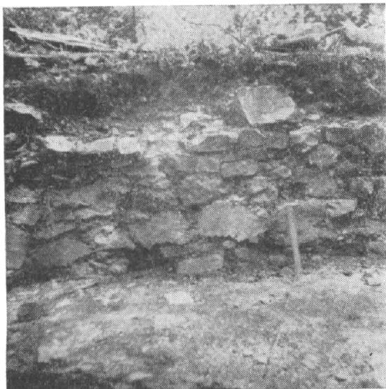
Obr. 6. Kolačno „Michalov vrch“, okr. Topoľčany. Sonda II/74 – detail muriva stavby I. Foto: J. Császta.
