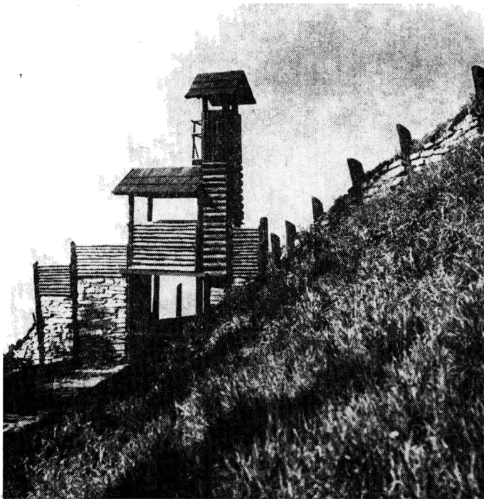
Obr. 5. Liptovská Mara — Havránok. Rekonštrukcia vstupnej brány vnútorné- ho pásma opevnenia hra- diska z 1. stor. n. l.
