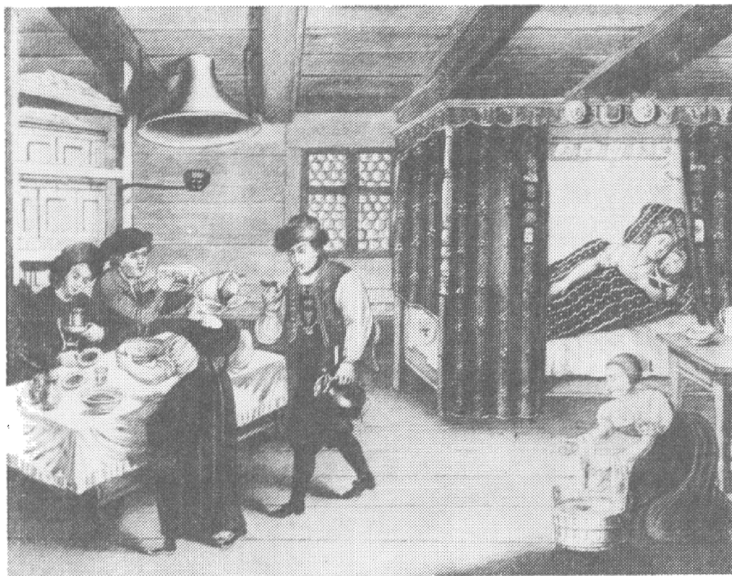
Obr. 4. Křtiny na Chebsku. Původní tříbarevný akvarel neznámého umělce pro spis S. Grünera. Na dřevěném rámovém bednění kamen je upevněn železný osvětlovací koš, nad nímž je dvěma železnými držáky upevněn, do trámů trámového záklopového stropu na sraz, trychtýřovitý keramický závěsný krb. Fotoreprodukce V. Srpa. Chebské muzeum v Chebu.
