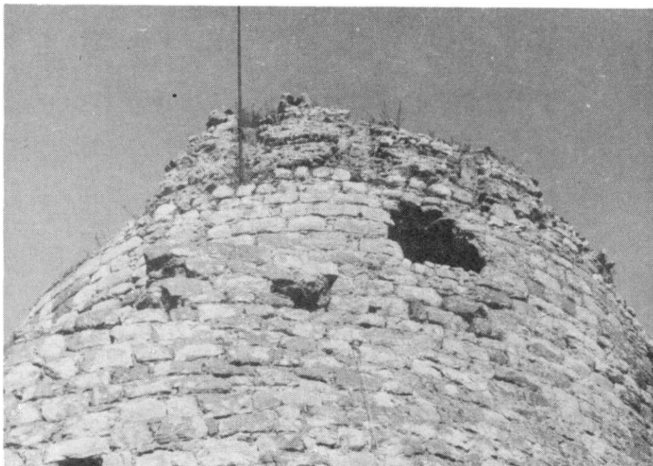
Obr. 5. Michalovce hrad, okr. Mladá Boleslav. Otisk trámové konstrukce na líci posledního patra bergfr.tu. Foto autor.
