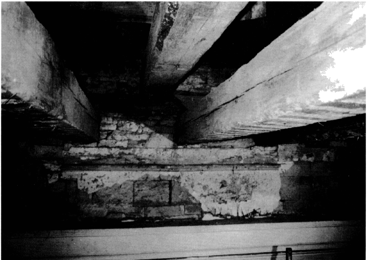
Obr. 12. Cítov (o. Mělník). Kostel sv. Linharta – románské zdivo podkroví s fragmenty starší úpravy před nasazením barokního bednění fabionu.
